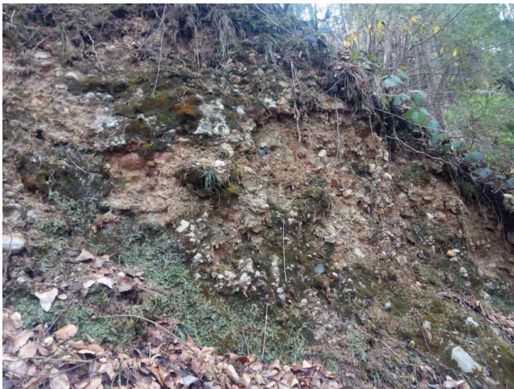
Slika 13: Matična podlaga konglomerata nad cestiščem
