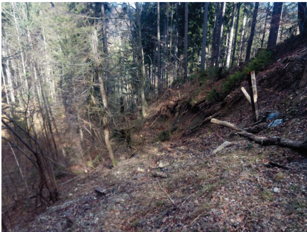
Slika 11: Stanje pod odlomnim robom
